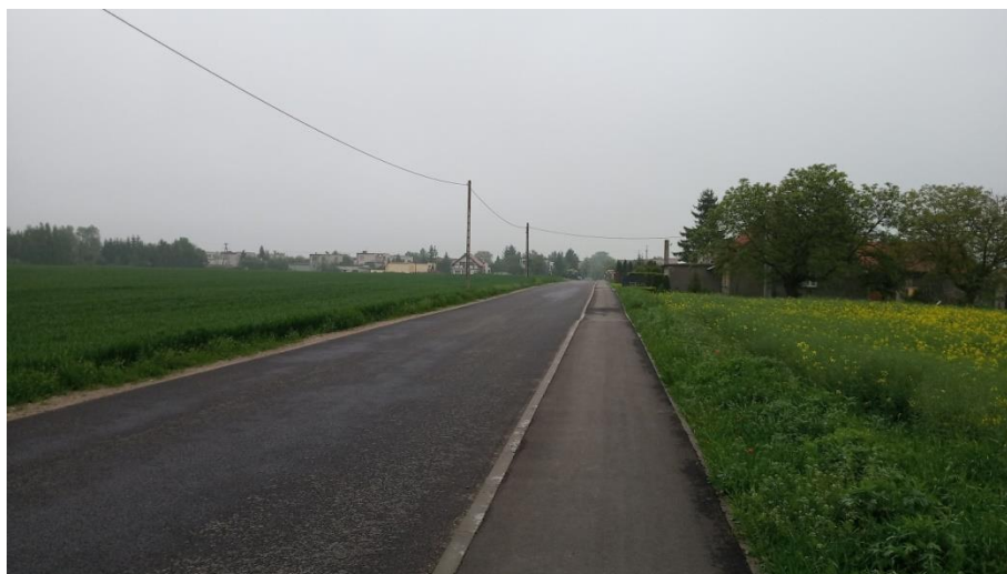
Fot. Droga Pruszcz – Mirowice
