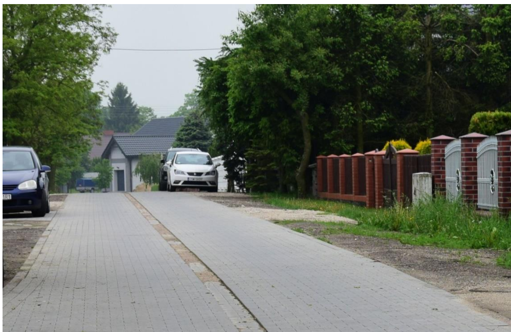
Fot. ul. Akacyjowa w Pruszczu
