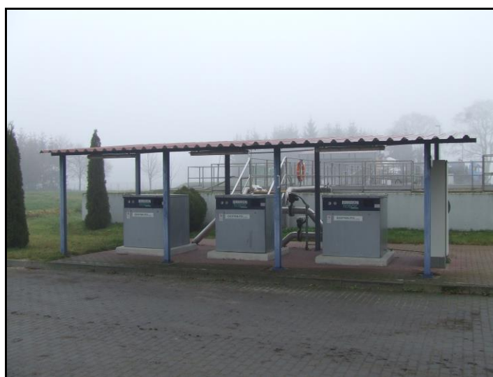
Ryc. 8. Stanowisko dmuchaw
